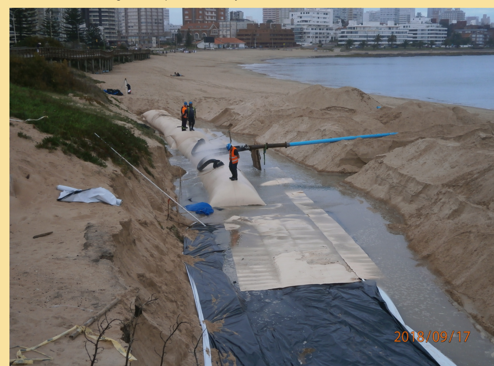
FOTOGRAFÍA: llenado de geotubos parada 12 Playa Mansa
