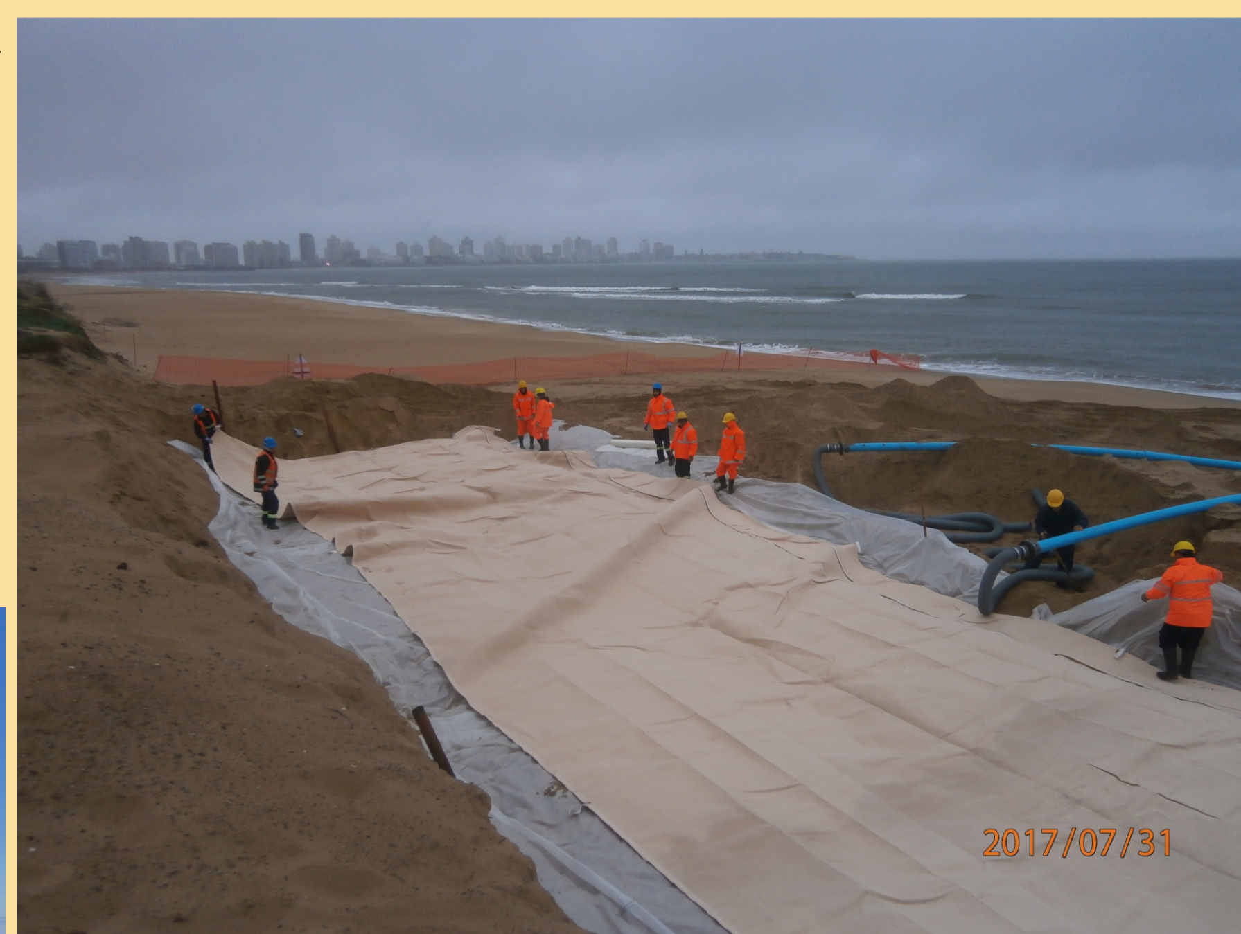
FOTOGRAFÍA: llenado de geotubos parada 12 Playa Mansa
