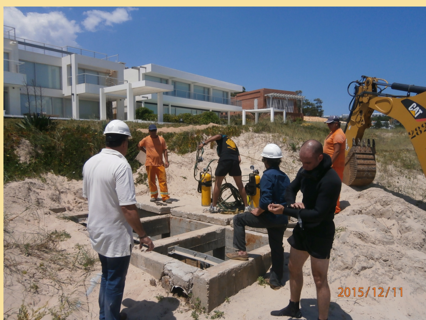
IMAGEN: Trabajo de mantenimiento de estación de bombeo del Dren Costero de Solanas
