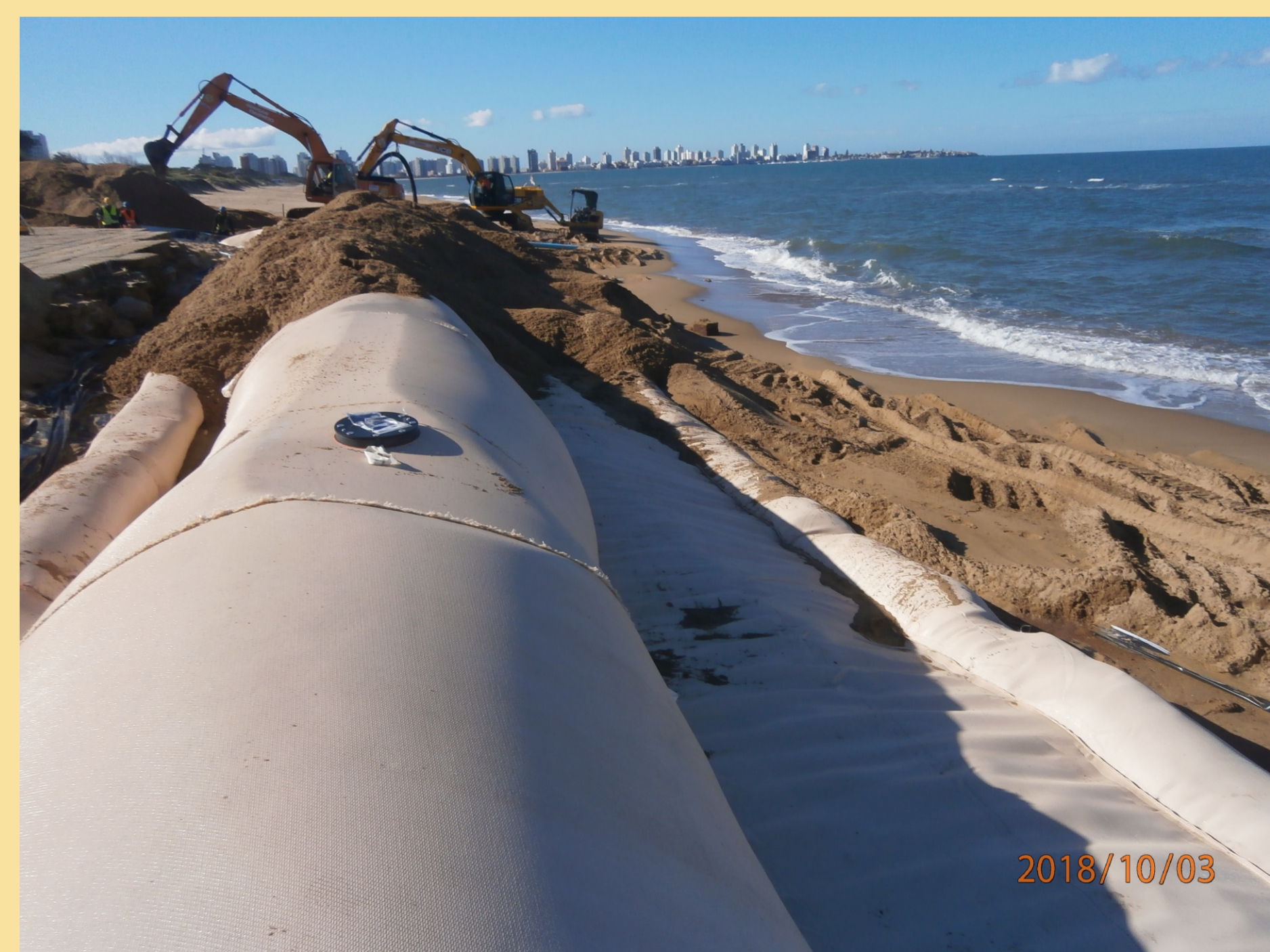
FOTOGRAFÍA: llenado de geotubos parada 12 Playa Mansa
